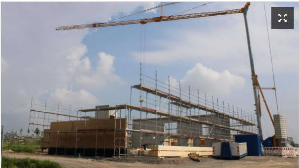
Noch nicht ganz so weit fortgeschritten ist der Bau des neuen Kita-Gebäudes in Besse. © Christina Zapf
